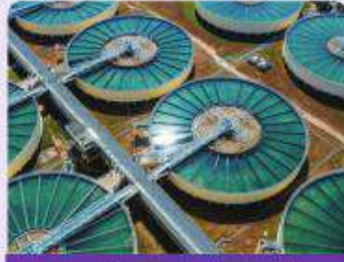
محطة معالجة مياه الصرف الصحي
