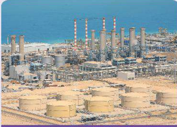
محطة تحلية المياه
